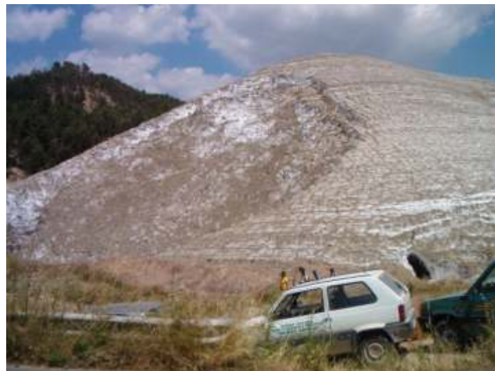
Discarica di sali interessata da dissesto franoso nell'area mineraria abbandonata di Bosco-Palo
