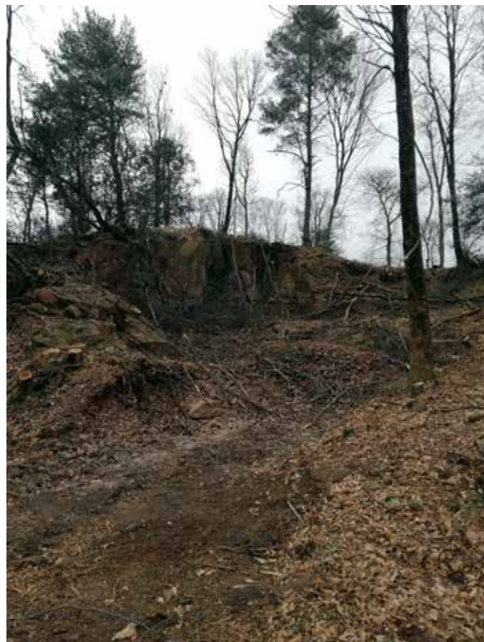
Figura 18 Lavori manutenzione straordinaria in una vecchia discarica in prossimità della cava Gebel. Foto autore.
